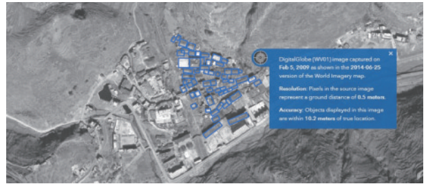
图7 鲁甸县某镇震前建筑卫星图
